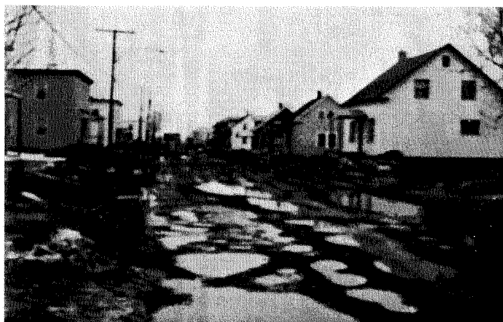
La rue Des Bouleaux pendant les travaux d'égouts et d'aqueduc le 25 mars 1976.
